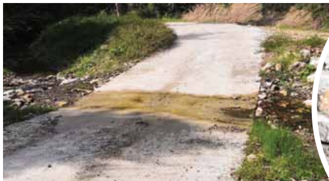
Slika 2: Armiranobetonska povozna mulda na gozdni cesti Stomarica.
