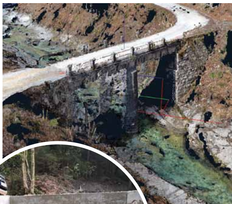
Slika 4: Primer visokokvalitetnega fotogrametričnega oblaka točk mostu Majnšk pri Idriji
