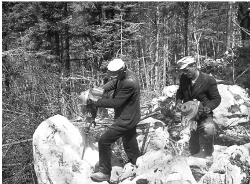
Motorni svedri, v tem primeru vrste cobra, so povečali učinek pri gradnji gozdnih cest v primerjavi z ročnimi, vendar tudi boleznimi. Cesta v Korn, Trnovski gozd, 1969. Foto: V. Klanjšček
