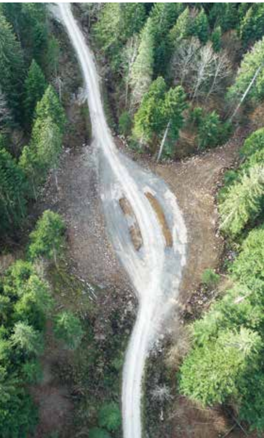
Vzdolžni dvostranski priključek vlak omogoča na preglednem delu javne ceste tudi obračanje gozdarskih transportnih kompozicij. Skladišče omogoča zlaganje ali rampanje.
