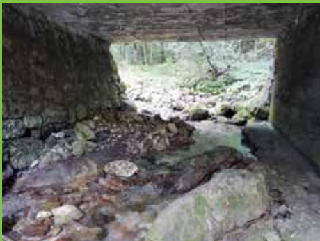
Rečno dno pod mostom na gozdni cesti.
