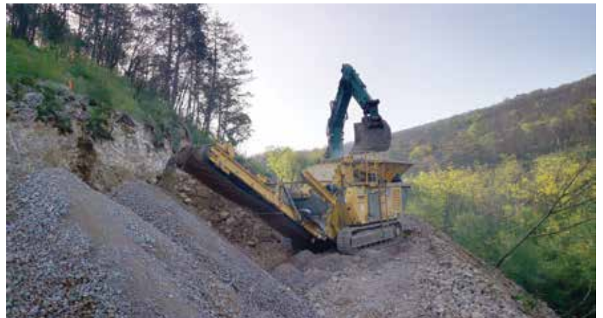
Mletje materiala na trasi novogradnje.
