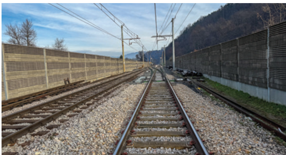
Odsek železniške proge v Zalogu, kjer so vgrajeni pragovi impregnirani z novo generacijo zaščitnih sredstev na osnovi bakra.
