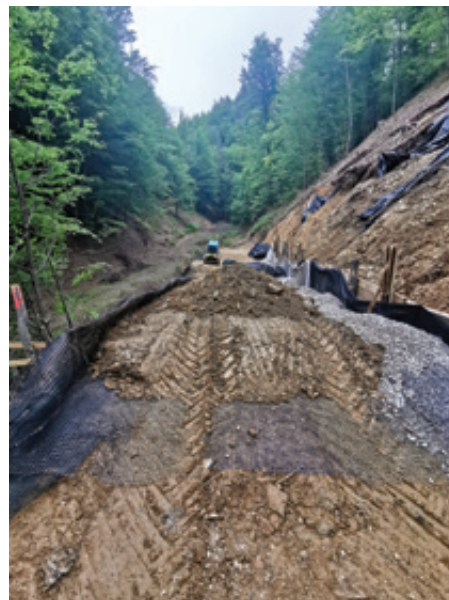
Slika 3: Gradnja podpornega zidu z armirano zemljino na območju usadov
