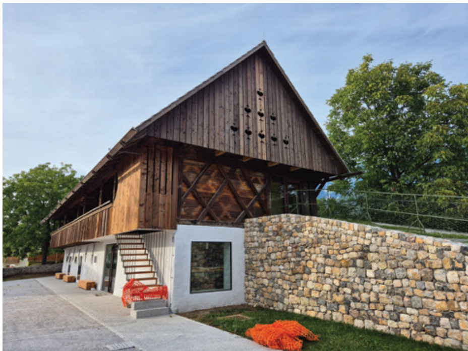
Kombinacija uporabe starega lesa in lesa, obdelanega z zeleno galico (v zatrepu), na prenovljenem gospodarskem objektu ob Prešernovi domačiji v Vrbi
