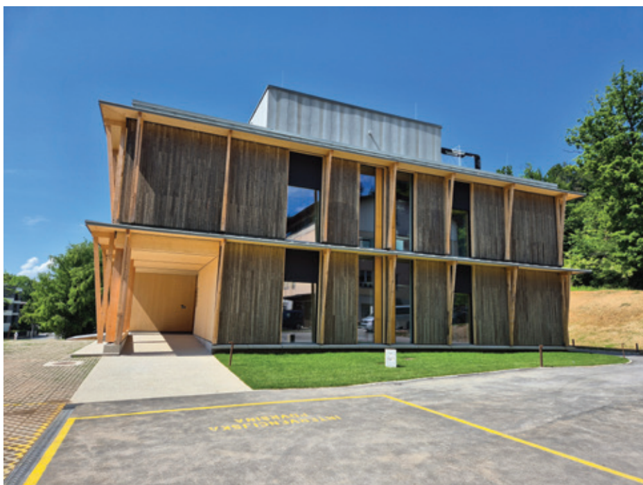
Fasada centra za semenarstvo, drevesničarstvo in varstvo gozdov je obdelana z železovim sulfatom.
