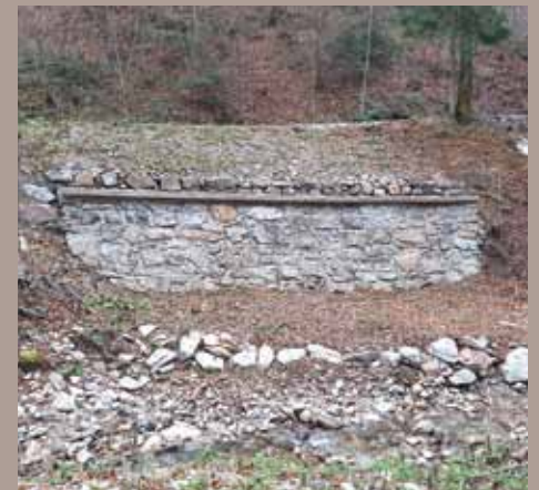
Dobra inženirska praksa pri sanacijah enostavnejših (zgoraj: Črna na Koroškem) in kompleksnih (spodaj: Idrija) zemljinskih plazov v državnih gozdovih.
