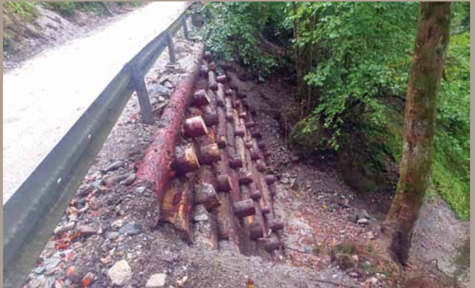
Dobra inženirska praksa pri sanacijah enostavnejših (zgoraj: Črna na Koroškem) in kompleksnih (spodaj: Idrija) zemljinskih plazov v državnih gozdovih.
