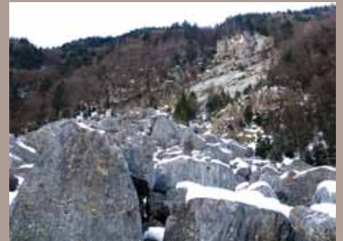
Kamninski plaz na severnem pobočju Javorščka v Bovcu.
